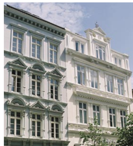
In alter Bausubstanz ist mit „Mängeln“ zu rechnen
